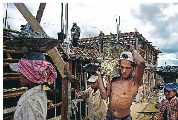
Bara på byggarbetsplatserna syns större grupper människor. Här byggs ett sjukhus.
